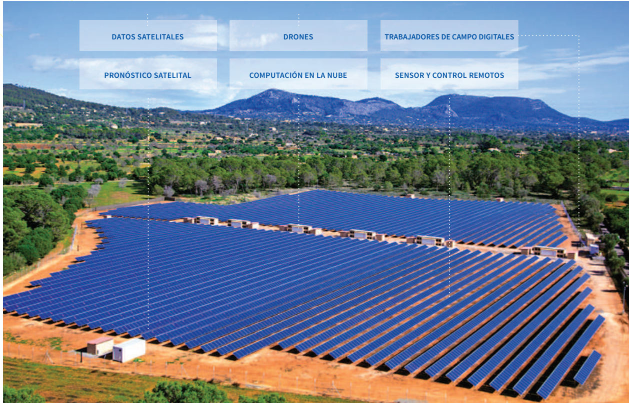
FIGURA 5 OPERACIONES DIGITALES Y MANTENIMIENTO DE PARQUES SOLARES A NIVEL SERVICIOS PÚBLICOS.
