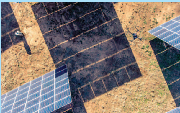
Inspección a un parque solar.
